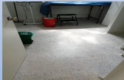
Piso Sala de Citología
