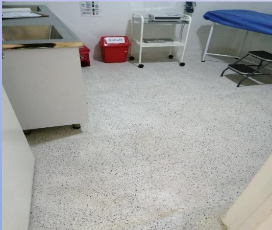
Piso Sala de procedimiento
